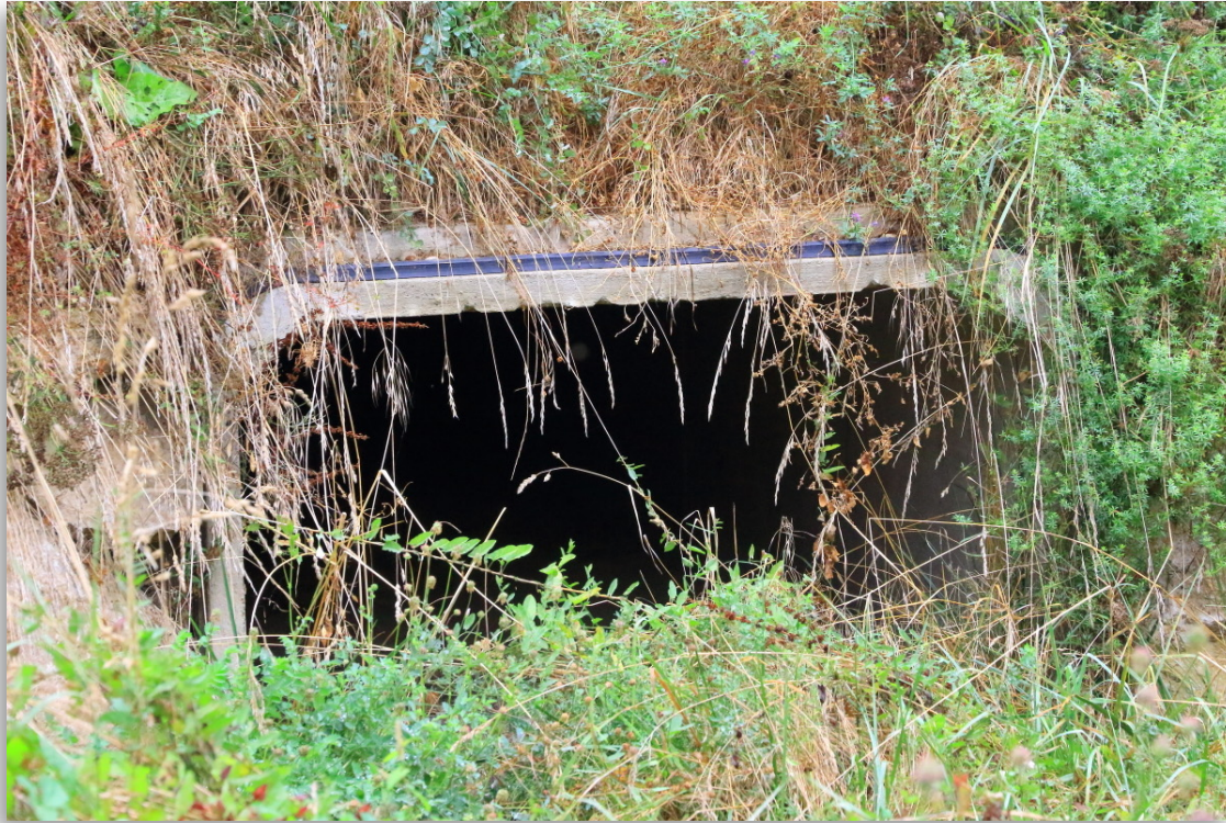
Passage à petite faune sous la voirie d'accès à l'hôpital
